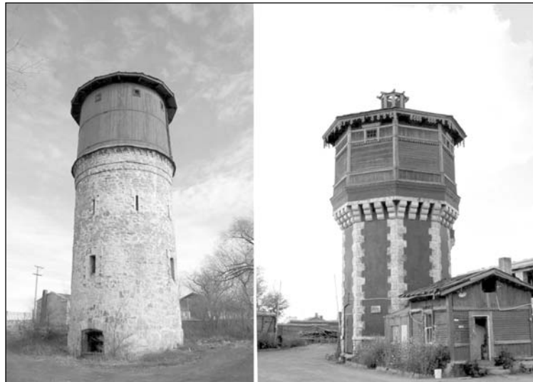
Слева – типовая цилиндрическая водонапорная башня станции Чжалайнор (120 тонн), построенная по стандартному проекту. Справа – башня-близнец из Маньчжоули с шестигранным основанием и восьмигранной деревянной «коронай» (фото 2010 г. до реставрации). Разница в исполнении очевидна: башни Маньчжоули создавались как архитектурные доминанты, а не просто утилитарные объекты.
