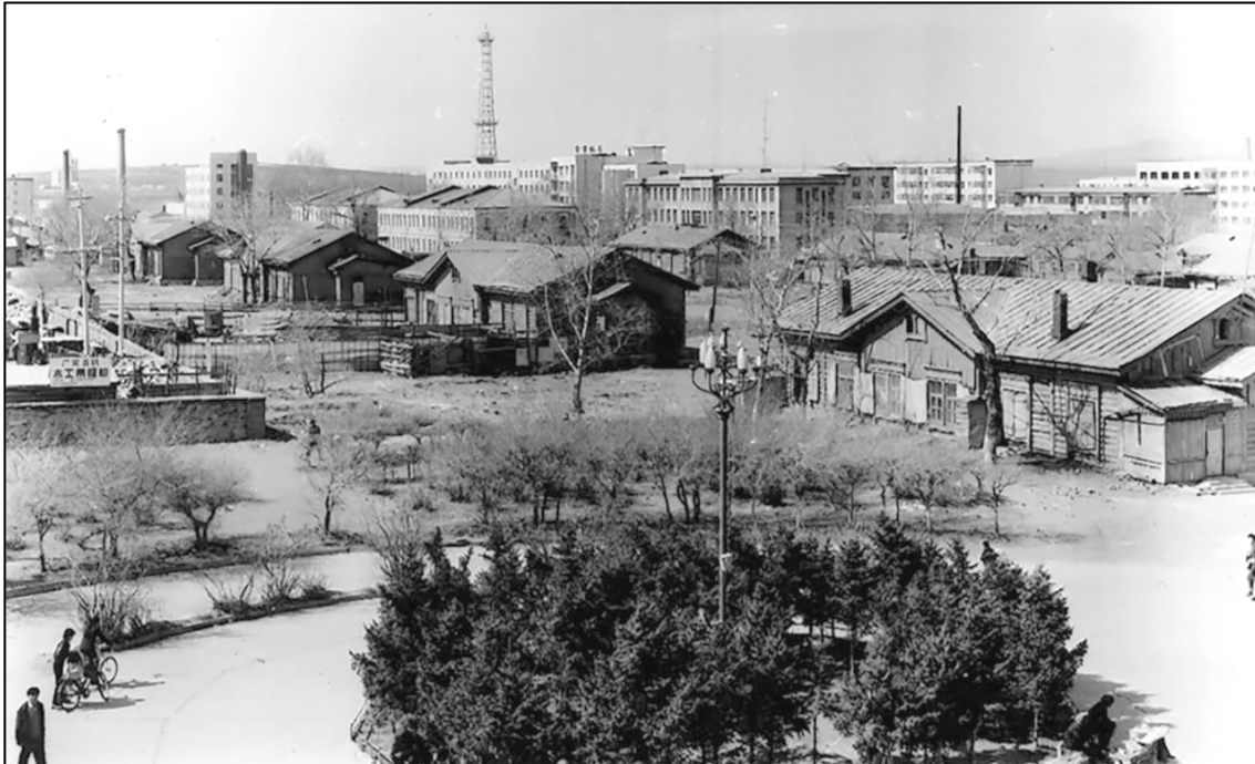
Телеграфная улица в Маньжоули, фото 1996 г. Деревянные дома бревенчатой кладки в стиле «мукулэн» строились в северной части города, принадлежавшей Забайкальской железной дороге.
